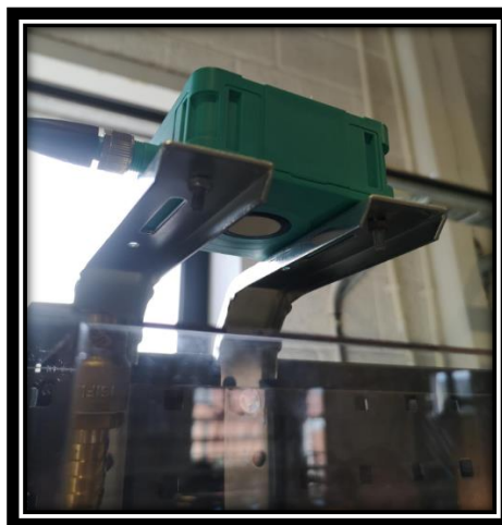
Figur 5-5: Ultralyd nivåmåler plassert over vannmagasinet.
